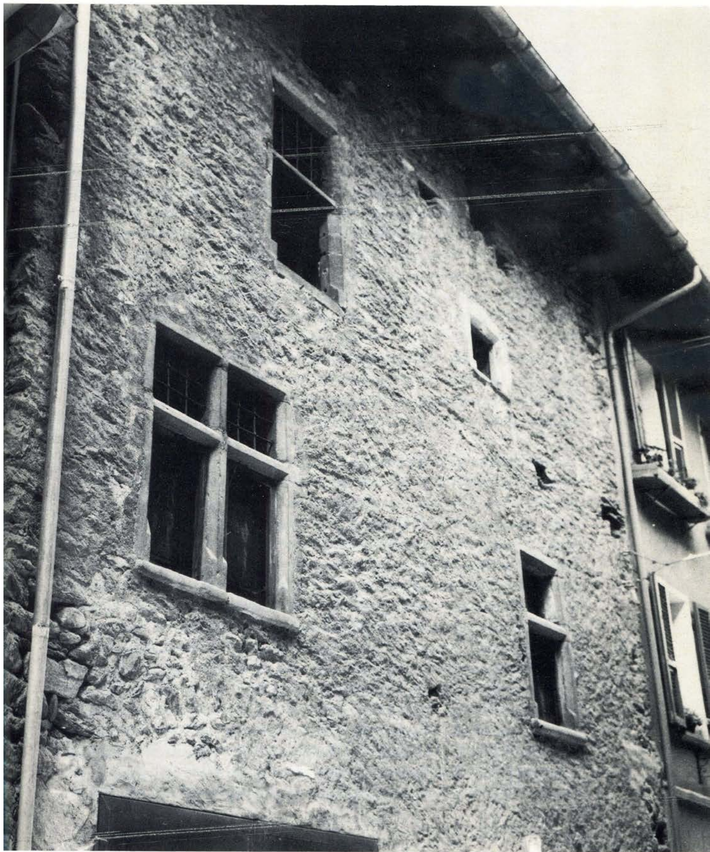
Donnas. Edificio situato nel Borgo con finestre in pietra: una a crociera, una ad accolade ed altre due divise orizzontalmente.
