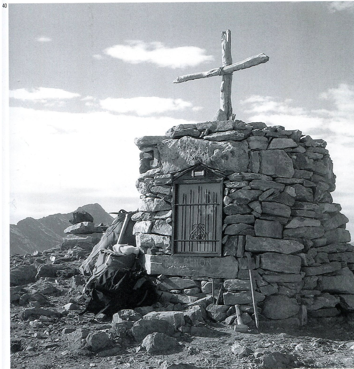
40. Anno 2005 - L'oratorio dopo i lavori di ripristino.
