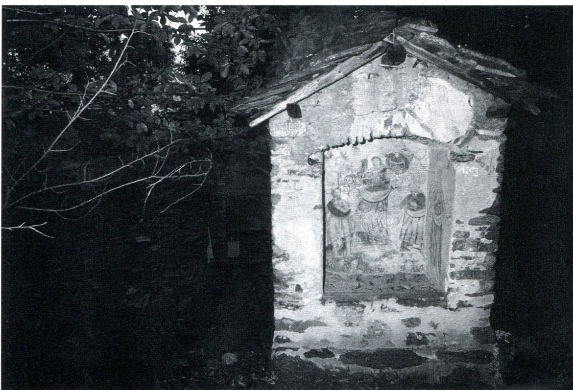
25. L'oratorio di Piahe fotografato prima dell'inizio dei lavori di restauro.
